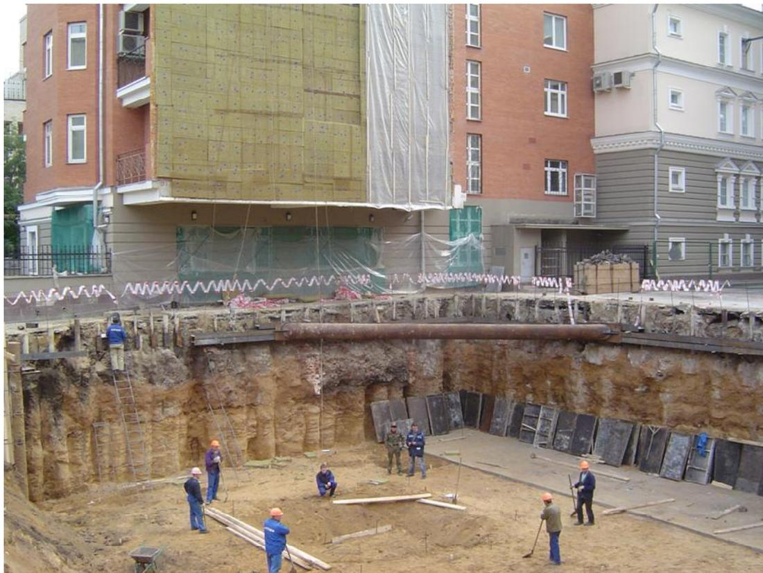
Рис. 5 Пример устройства ограждающей конструкции из грунтоцементных свай
